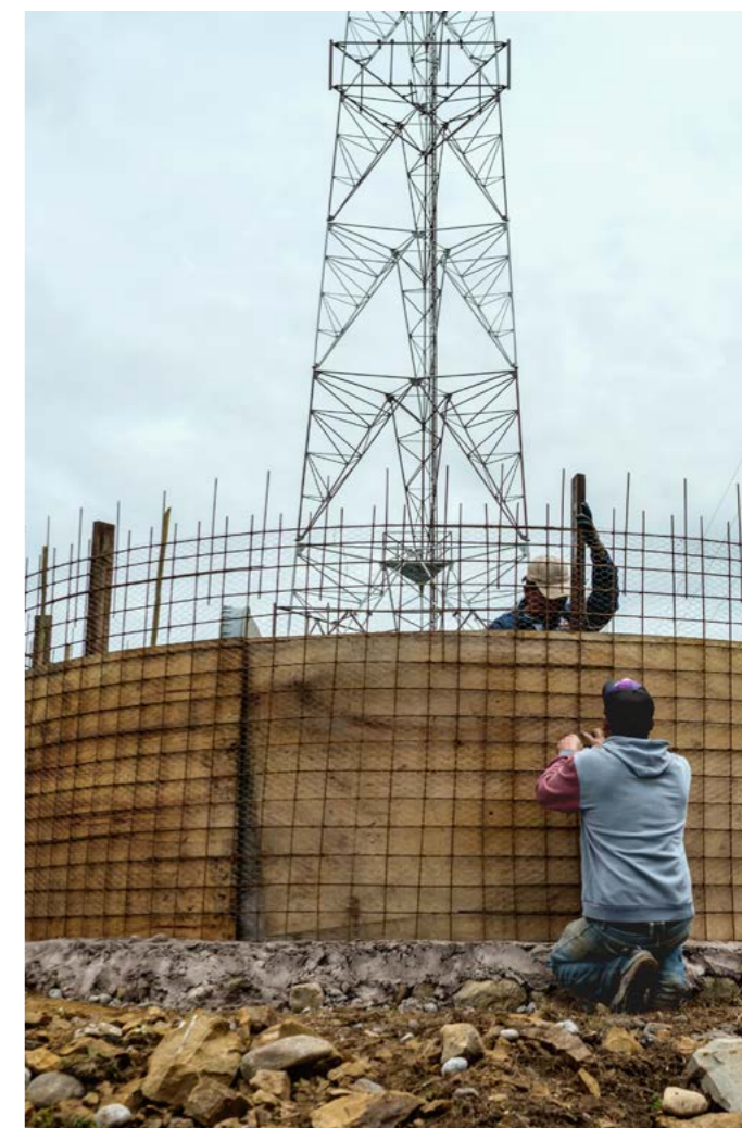
David Velazquez beim Bau eines Wassertanks
